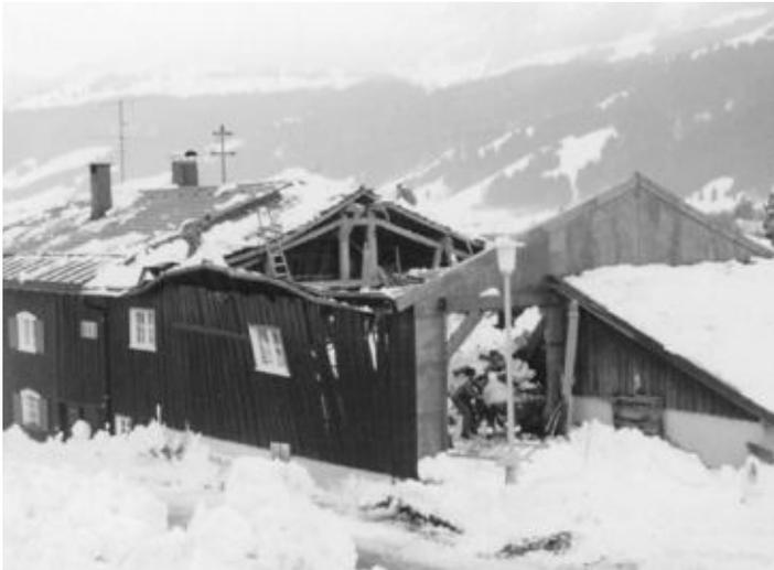
Dach durch Schneelast eingebrochen bei Mohr in Lamprechts.
